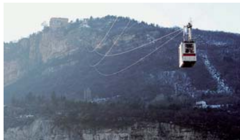
Verso il Bondone La funivia di Sardagna: da anni si ragiona di un grande impianto
