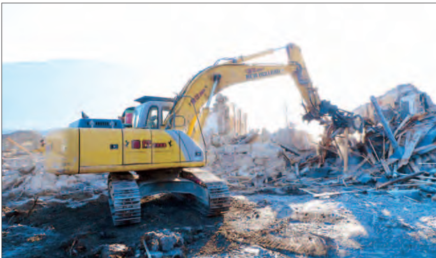
A sinistra una ruspa al lavoro per l'abbattimento delle vecchie caserme, ora rase al suolo (vedi sopra) per fare posto al nuovo ospedale. A destra l'area di progetto
