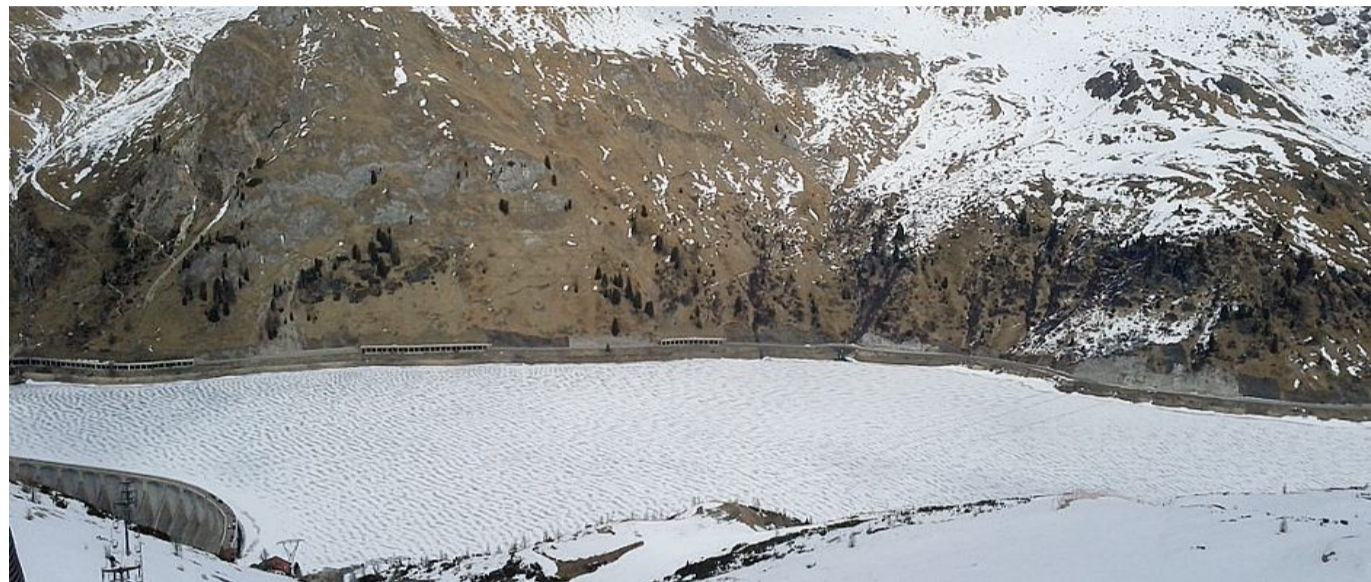
Sulla strada che costeggia il lago Fedaiia sono evidenti i paravalanghe già costruiti, ma ugualmente ci sono tratti dove la sicurezza non è garantita
