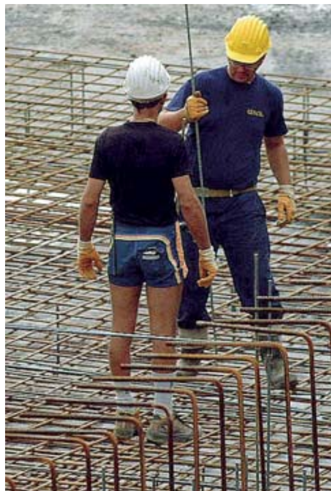
Cantiere Due operai al lavoro in un cantiere
