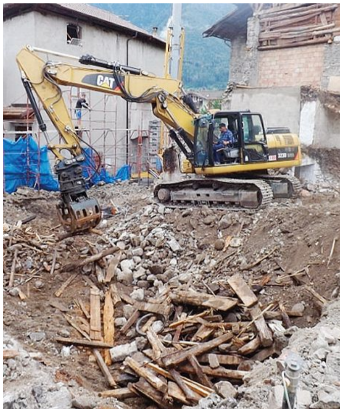
Il cantiere di Tione dopo l'abbattimento dell'edificio
