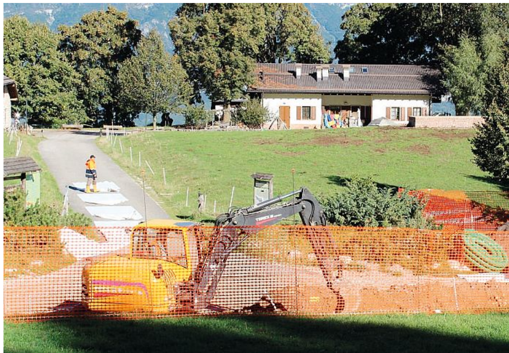
I mezzi da scavo visti da un'altra angolazione e sullo sfondo l'agritur
