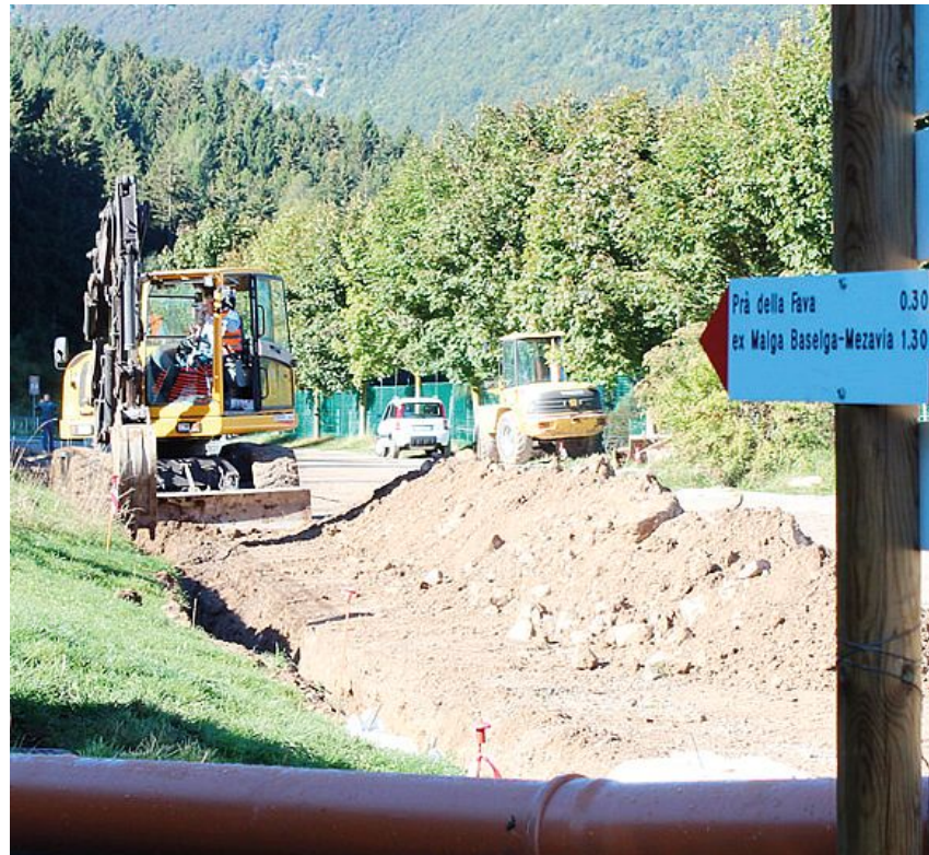
Escavatori al lavoro per la realizzazione di un parcheggio e il cartello che il Servizio gestione strade e parchi del Comune ha collocato nel cantiere
