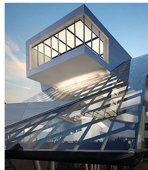
Un dettaglio della nuova struttura alla Baltera
