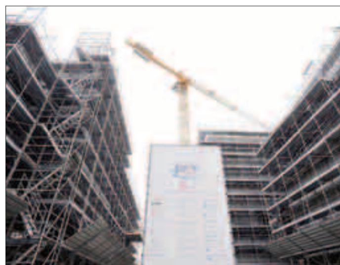
L'edificio in costruzione alle Albere, convertito ad uso biblioteca (A.Coser)
