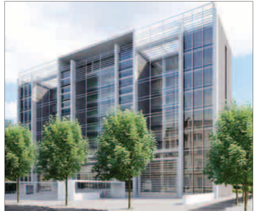
Ecco come sarà l'ingresso agli uffici comunali da via San Giovanni Bosco
