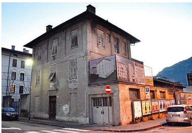
L'ultimo vecchio edificio di via Flaim: l'abbattimento è ormai prossimo
