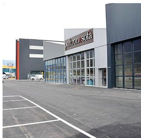
Il fronte nord (in alto) e quello est del complesso
