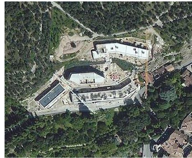
La volumetria totale del compendio è di 21.270 metri cubi
