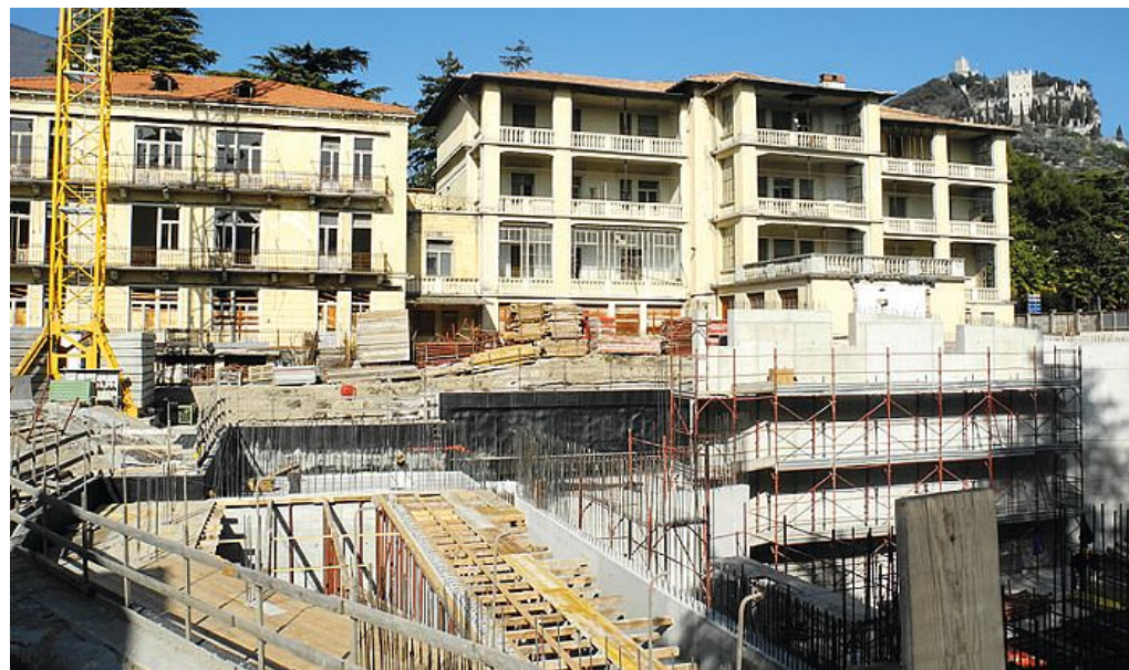
Il cantiere (fermo ormai da due anni) del teatro auditorium all'ex Quisisana di Arco (foto Galas)
