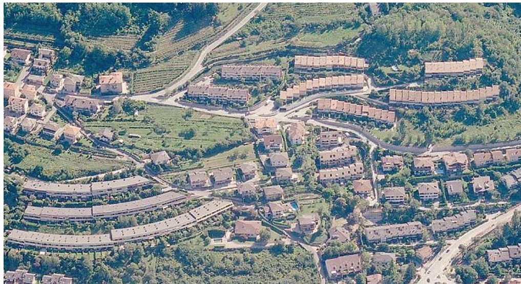
Con la riforma urbanistica approvata ieri dal Consiglio provinciale maggiori poteri a Comuni e Comunità di valle
