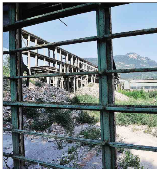
Dalle coperture dei capannoni sono state tolte le lastre di amianto, ora le strutture
