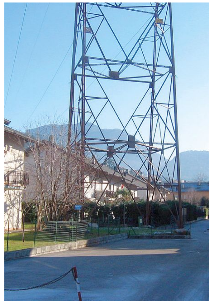
I tralicci dell'attuale elettrodotto sopra le case in via Marzola
