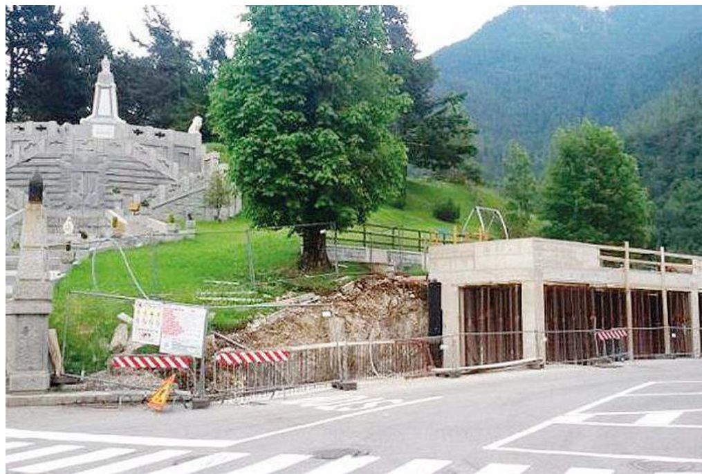
Il cimitero monumentale ed il cantiere col “porticato” in costruzione. Per l’opera sono stati stanziati 251.240 euro
