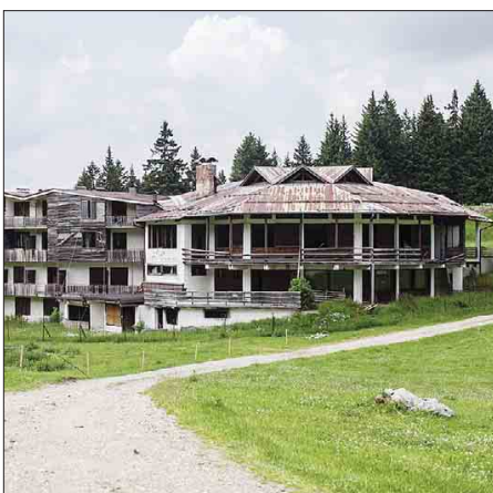
Il complesso alberghiero «Tavola Calda» in stato di abbandono a Trenzalzo
