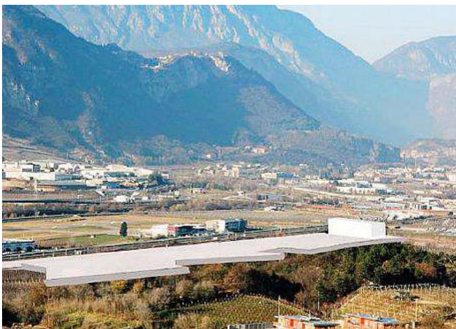
In alto l'area in via al Desert, qui sopra l'area di Mattarello con i volumi
