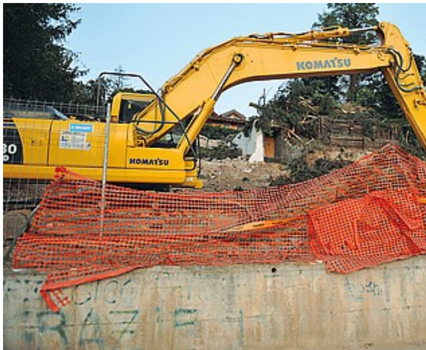
Cantieri Un escavatore in azione. In Trentino i Prg consentono ancora margini per nuove costruzioni
