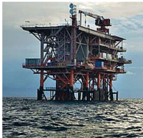
Sotto la lente Un impianto di trivellazione in mare
