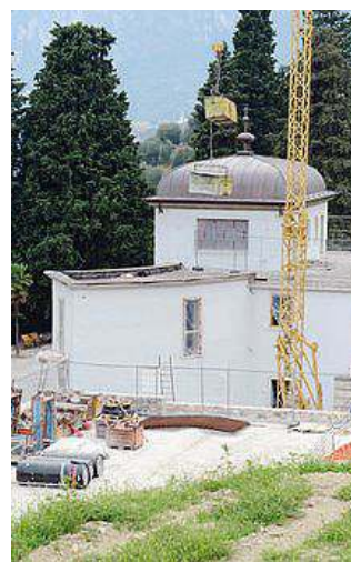
I lavori a Villa Miravalle
