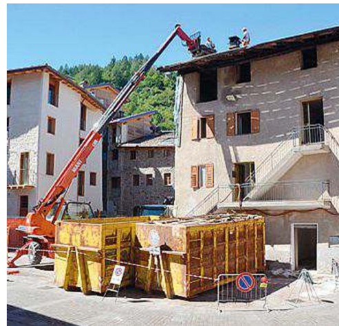
Lavori demolizione di parte dell'ex casa Sevegnani
