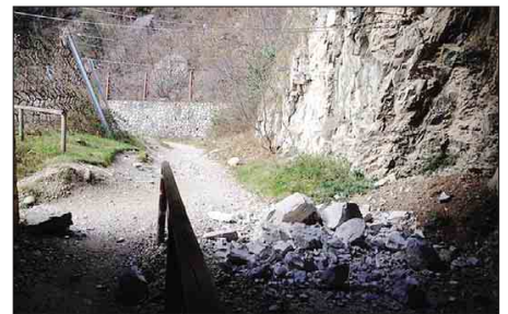
Una delle frane che ha interessato la vecchia Ponale
