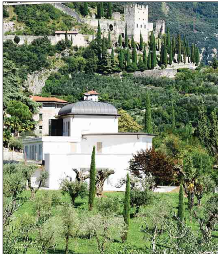
Uno scorcio di Villa Miravalle (sullo sfondo il Castello di Arco)
