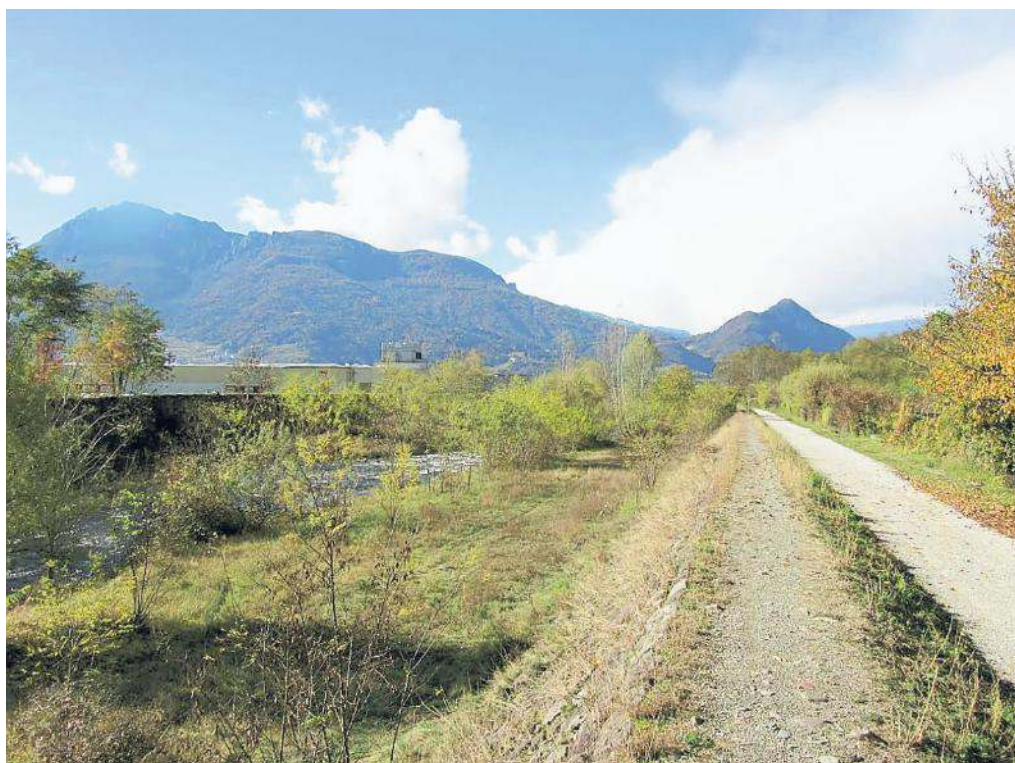
Uno dei nuovi impianti idroelettrici sul Fersina è previsto all'altezza della Cooperativa Sant'Orsola
