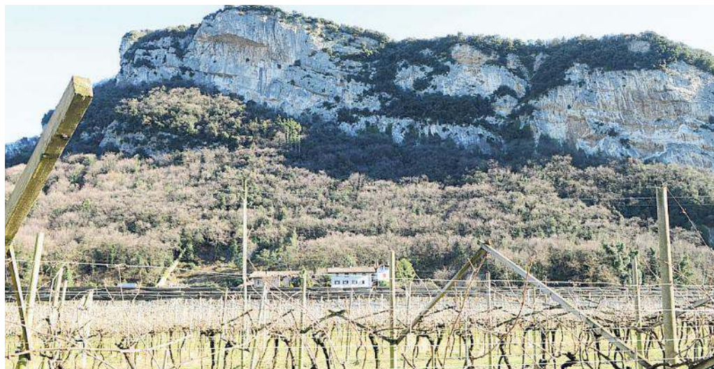
Il monte Brione rappresenta un grosso pericolo per il rischio frane: il Comune vuole realizzare un vallo tomo
