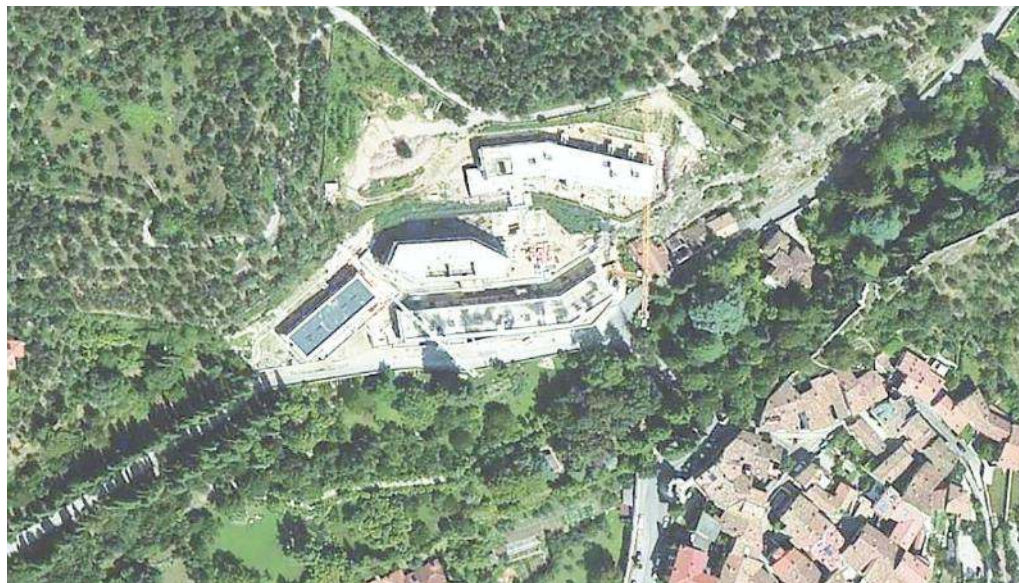
Il complesso ex Argentina visto dall'alto: l'immobile è al centro di una complessa vicenda giudiziaria
