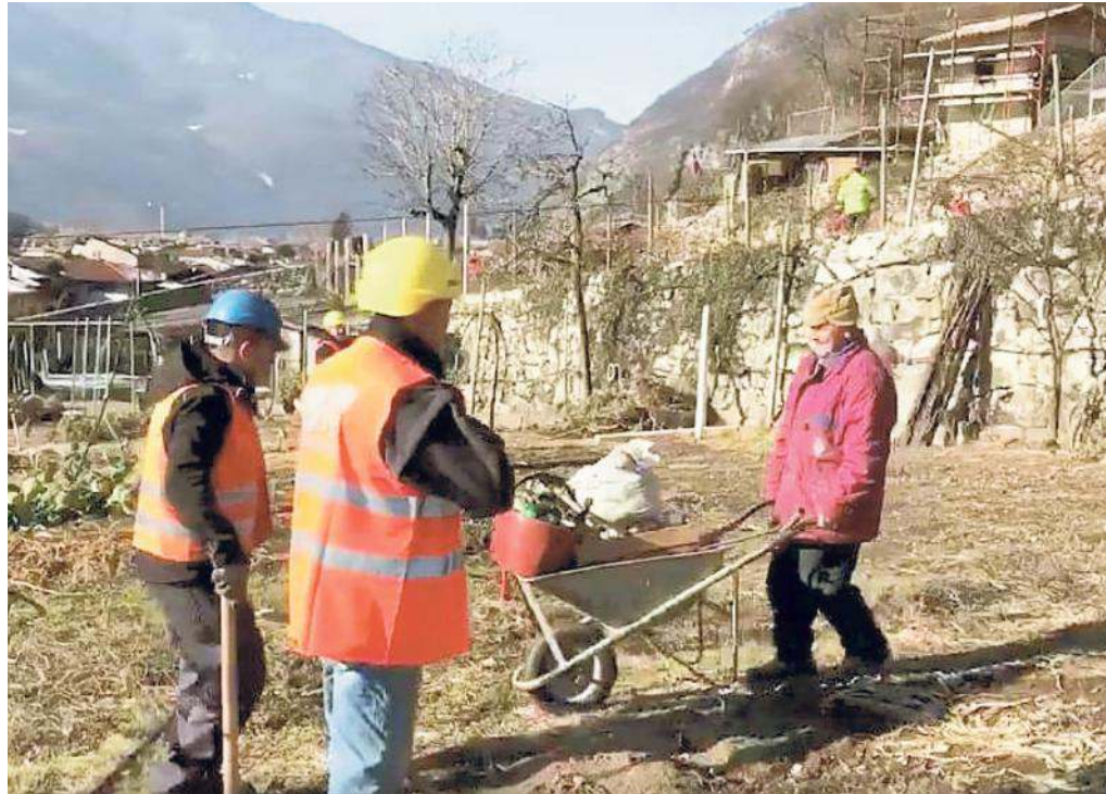
Gli operai nel cantiere del vallo tomo sulle fratte di Mori fermo da mesi per la protesta dei cittadini
