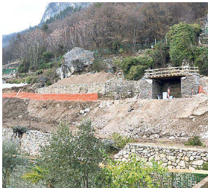
I lavori del cantiere del vallo-tomo, sui terrazzamenti di Mori
