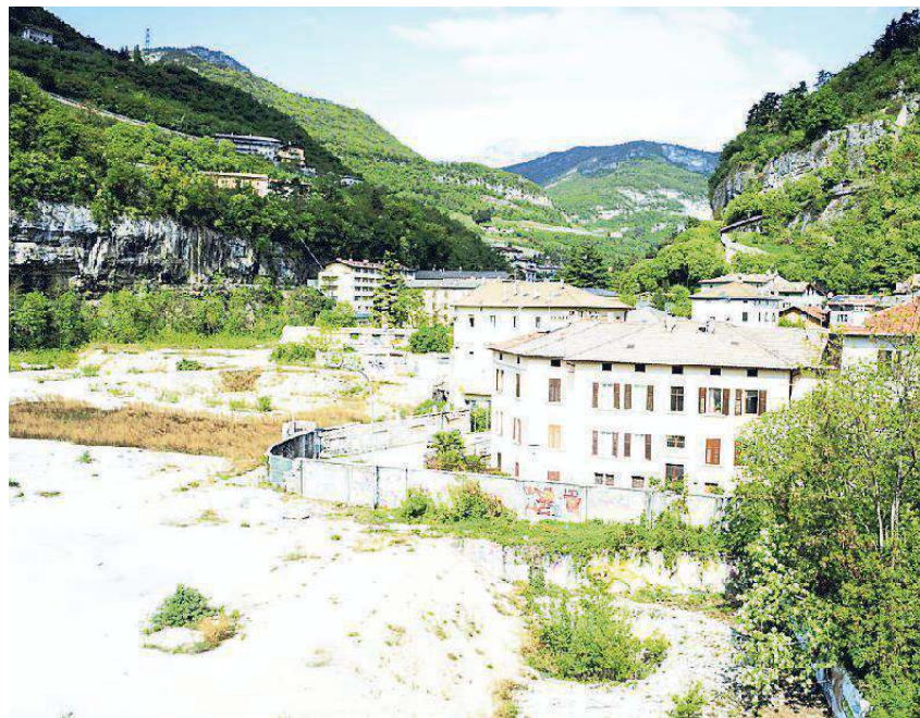
Ad inizio estate 2018 il centro polifunzionale aprirà i battenti sull'area ex Italcementi
