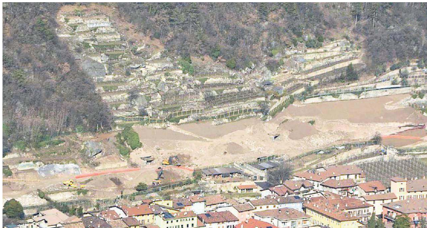
Visto dall'alto lo sbancamento tra le case di Mori e la base del pendio fa impressione
