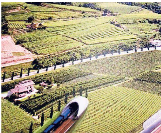
Il tunnel del Brennero passerà sotto Faedo. L'incognita ai Sorni
