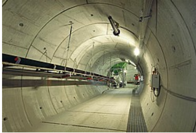
Grandi opere Uno degli scavi per il Tunnel di base
