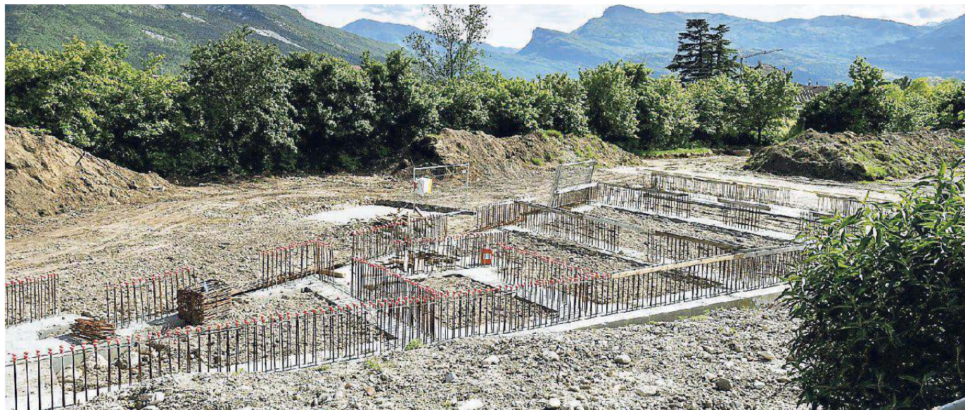
Il cantiere lungo il Leno: completate le fondamenta. Si punta ad aprire la struttura con il pattinaggio, nel prossimo inverno (foto Matteo Festi)
