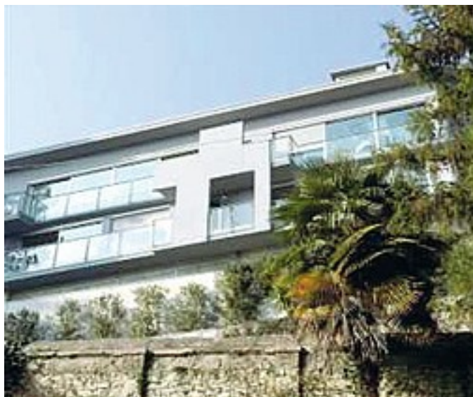
Appartamenti L'ex Argentina di Arco è stata trasformata in un comendio residenziale
