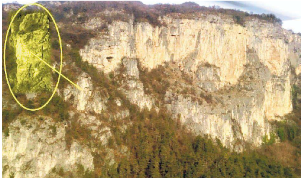
Nella zona evidenziata, il diedro roccioso sopra l'abitato di Mori che verrà demolito per l'estate
