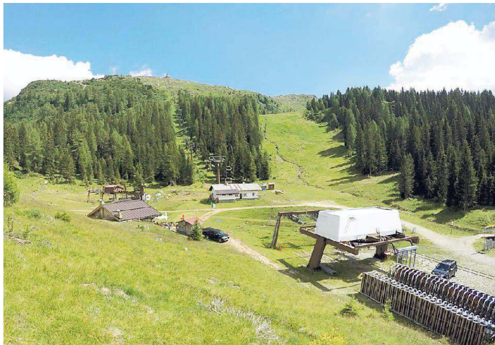
Gli impianti della ski area Paradiso sul passo Rolle: saranno rilanciati oppure smantellati?
