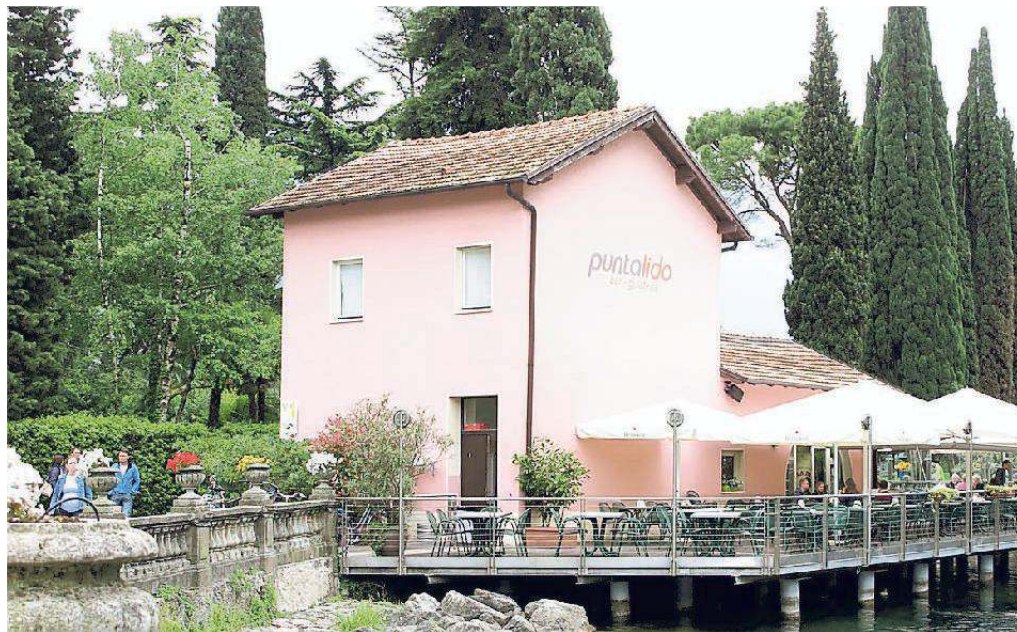
Il progetto per la gelateria Punta Lido, fortemente contestato, prevede la completa demolizione e ricostruzione
