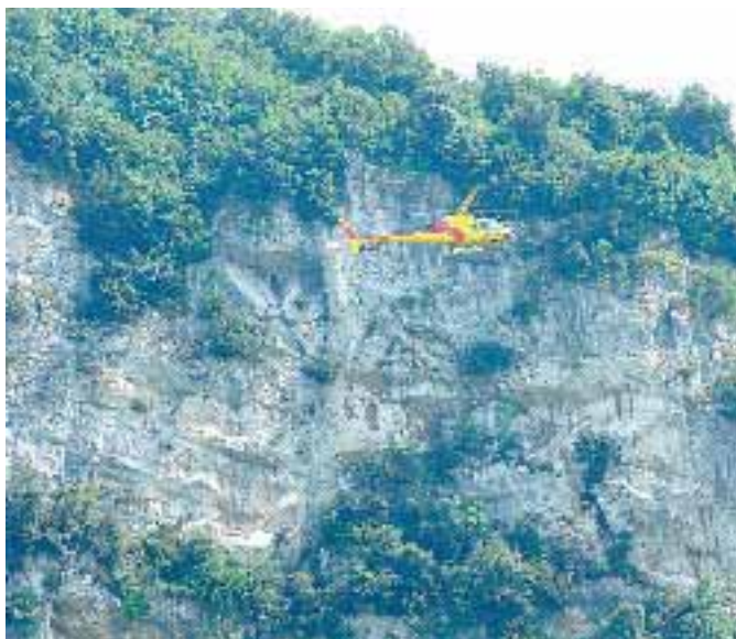
Un sopralluogo in elicottero sulla parete del monte Brione
