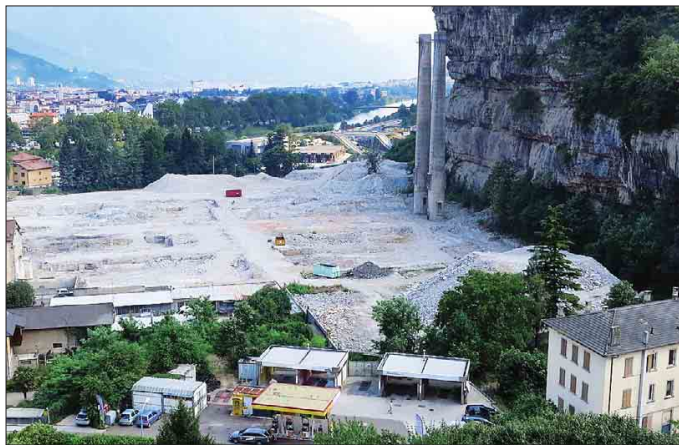
L'area ex Italcementi di Piedadcastello con le due ciminiere in stato di degrado e la parete rocciosa instabile
