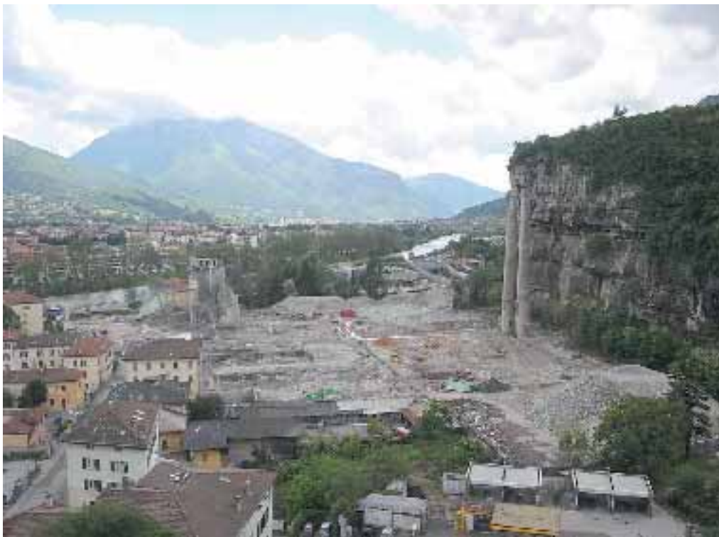
Un'immagine ai tempi della demolizione dell'ex Italcementi: ora il dilemma è se abbattere e no le ciminiere
