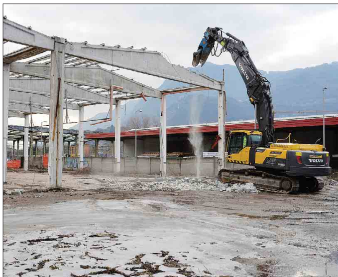
Il primo «colpo» dell'escavatore con pinza idraulica alla struttura in cemento (foto Coser)
