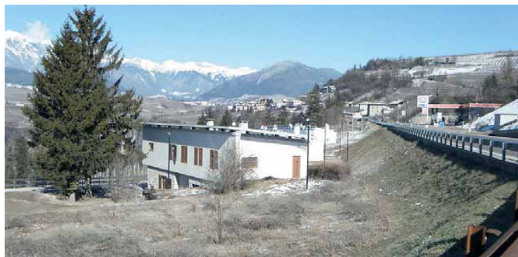
Il "villaggio Edison" a Taio costruito negli anni Cinquanta per le maestranze impegnate nei lavori della centrale
