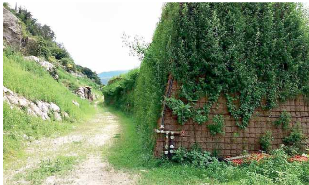
I lavori di "abbellimento" del vallo-tomo di Mori verranno eseguiti in due distinti lotti
