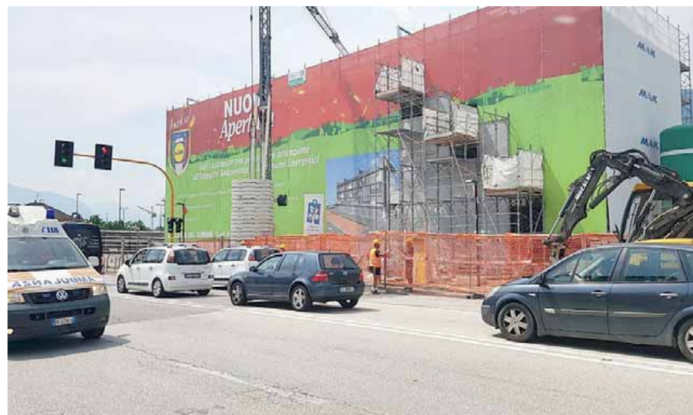
L'ex Frizzera con i lavori in corso per l'apertura del nuovo supermercato
