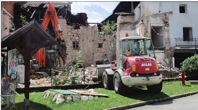
L'edificio in fase di demolizione
