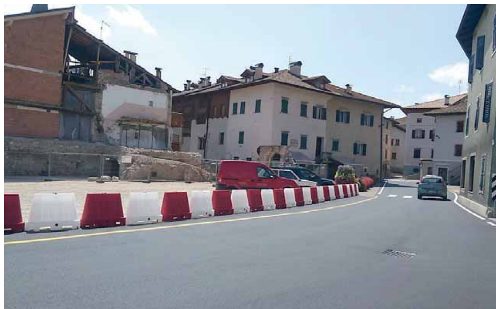
La demolizione di una vecchia casa a Romeno ha eliminato una strozzatura della viabilità e ampliato la piazza
