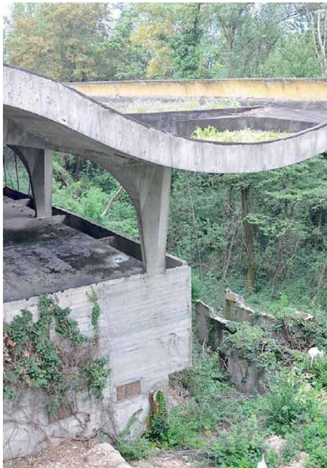
Ex Anmil: il presidente Rossi prevede la demolizione in novembre
