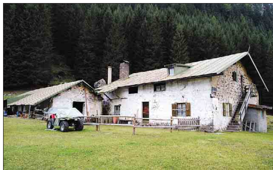
Malga Valsolero: qui è prevista la ristrutturazione della casera per avere 20 posti letto
